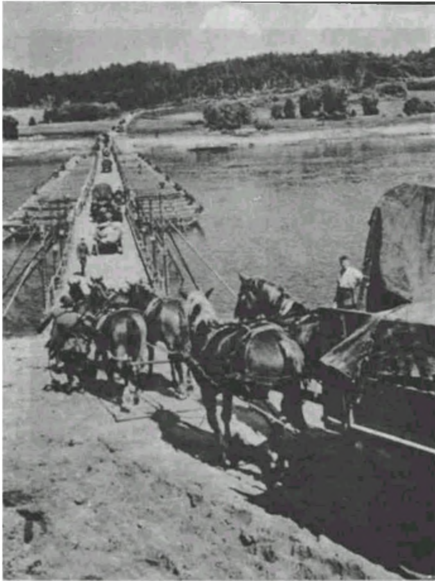
Una columna de retaguardia alemana, en el mejor estilo de la época napoleónica. atraviesa un pontón armado sobre un río, en dirección al mar Báltico, en el avance contra la Unión Soviética.
