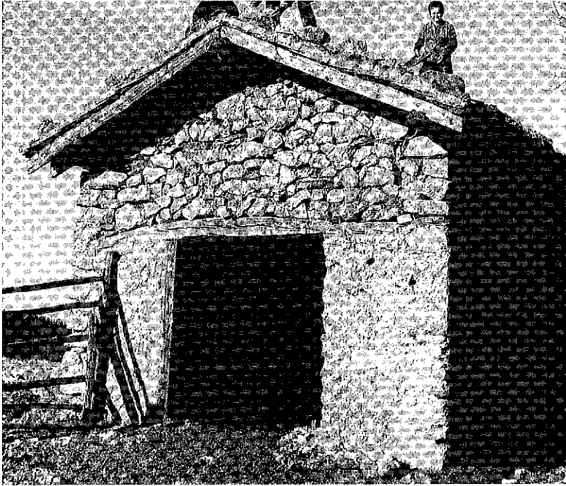
CASERIO SAKABI-BERRI. DEBA. 1976. Arreglando el tejado de la borda para refugio del ganado vacuno que se cria en el monte en estado semisalvaje y distinto del estabulado en casa para leche. (Foto: Anes.)
