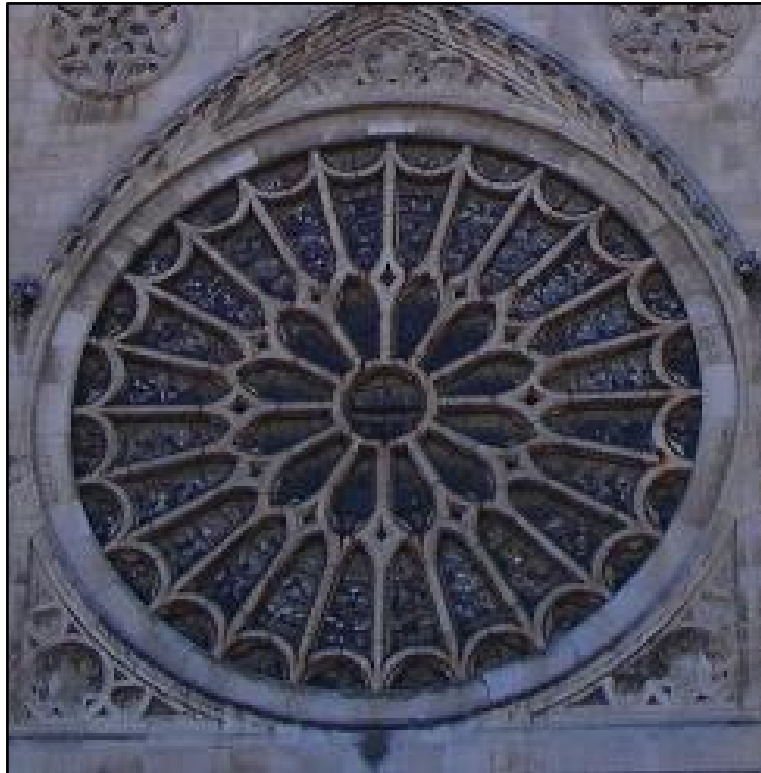
Rosetón de la fachada principal con 24 divisiones
