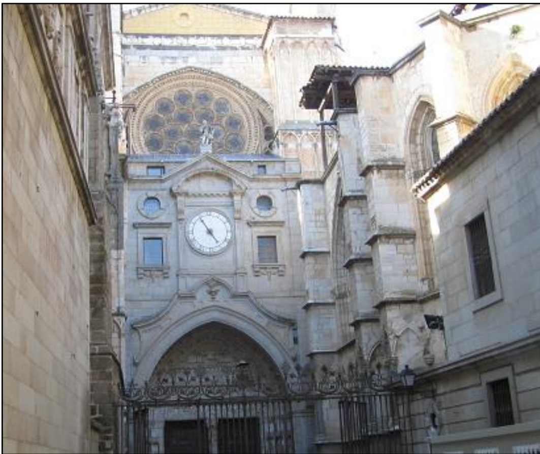
Detalle de la fachada norte con el rosetón de 12 círculos exteriores Catedral de Toledo
