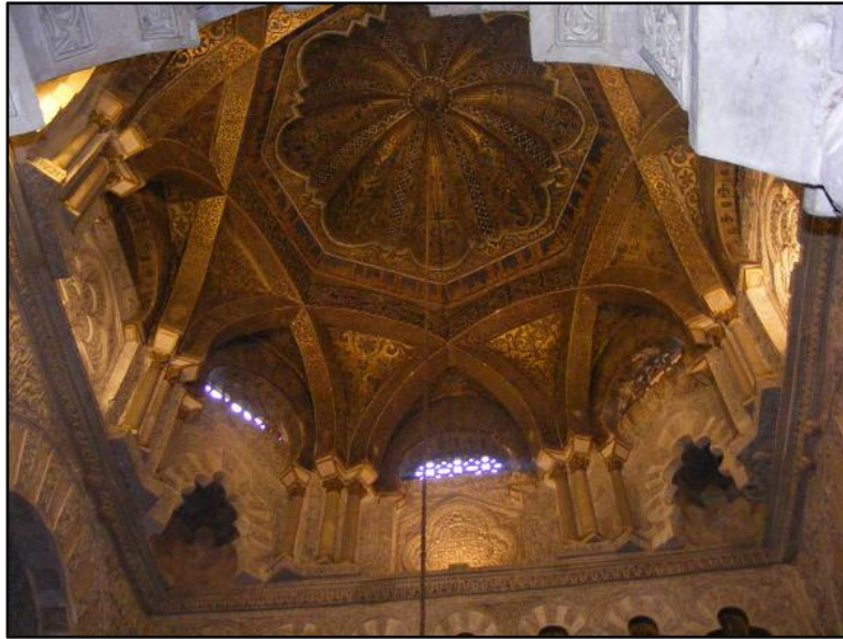
Bóveda octogonal central Mezquita de Córdoba
