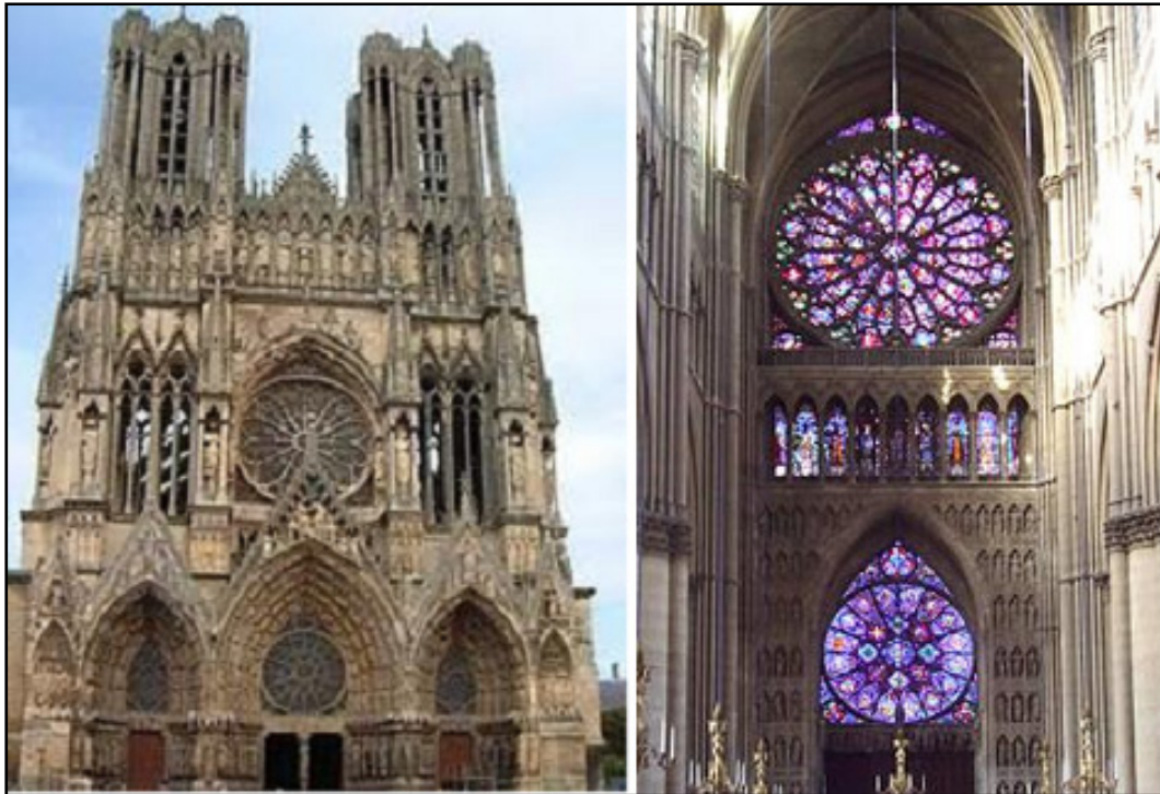
Fachada principal con dos rosetones de 12 y 16 divisiones
