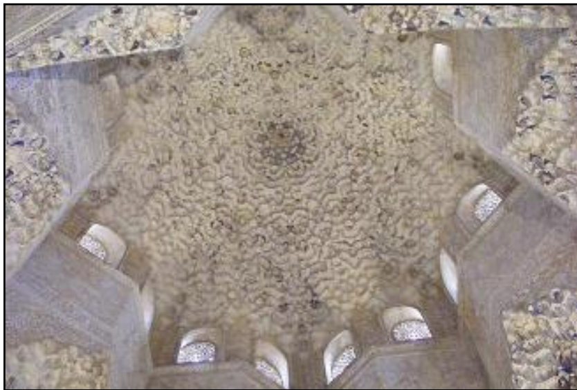
Bóveda con forma de estrella de la sala de los Abencerrajes
