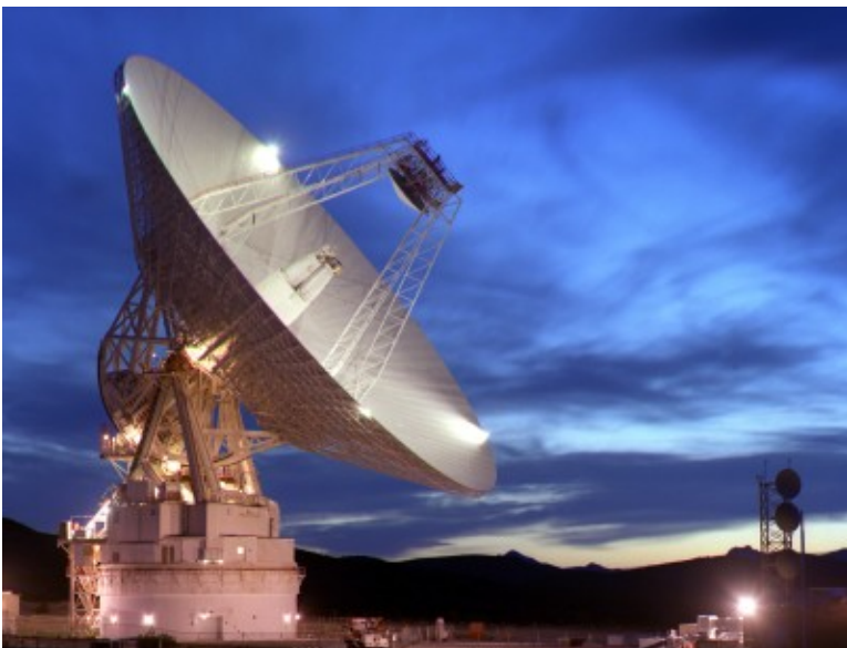
Imagen: Antena de 70 metros de diámetro de la red de espacio profundo de la NASA. (Foto: NASA)
