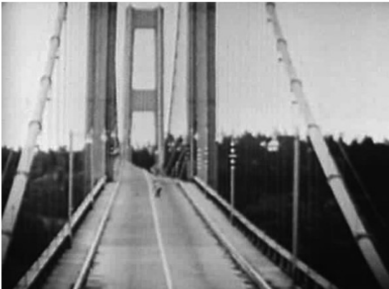
Imagen: El puente de Tacoma en pleno proceso de resonancia. (Foto: archivos del autor)
