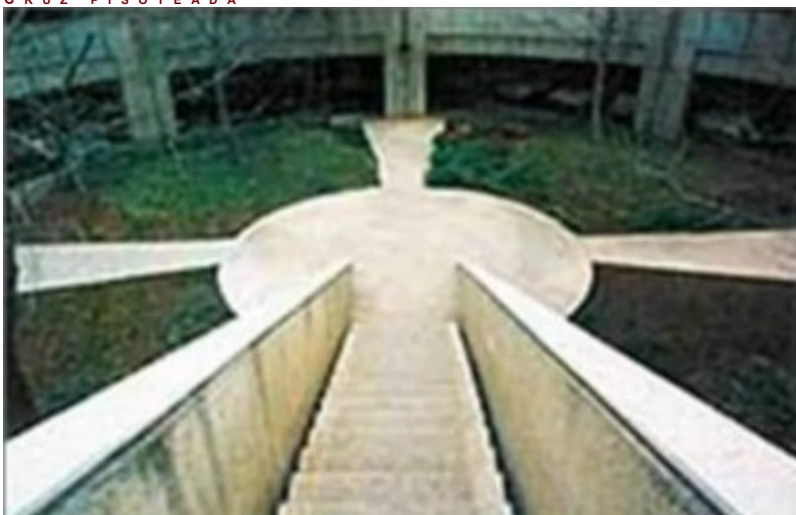
En el centro de las plazas de aparcamiento son las vías en forma de cruz cristiana. Jerry Golden ha mencionado que esta cruz ha sido específicamente incluida para ser pisoteado por los visitantes. Él es el más probable que tenga razón. En un edificio en el simbolismo espiritual reina, hay posibilidades de eficacia pequeños que el trazado de esas vías no han sido bien pensadas por los arquitectos. En otras palabras, esto no puede ser sólo una coincidencia. Los visitantes tienen que bajar las escaleras - simbólicamente "descender" a las esferas inferiores - para llegar a la cruz. Como te habrás dado cuenta, la importancia del acto de ascenso y descenso en este edificio es muy importante. Esto no es una excepción. Sociedades secretas ocultistas históricamente han estado en desacuerdo con la iglesia cristiana y repetidamente perseguidos y los acusaron de todo tipo de herejías. Durante la Edad Media los caballeros templarios (los antepasados de la masonería) han sido acusados por el Arzobispo de Canterbury de numerosas acciones anti-cristianas, entre ellos "pisotear la cruz bajo los pies" durante sus procesos de iniciación. ¿Están metiendo de nuevo en el cristianismo con este símbolo? G R A N A D A S
