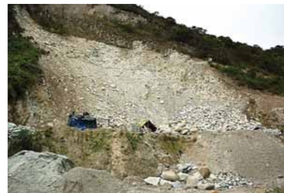
Derrumbe en la cantera de Saraguro
