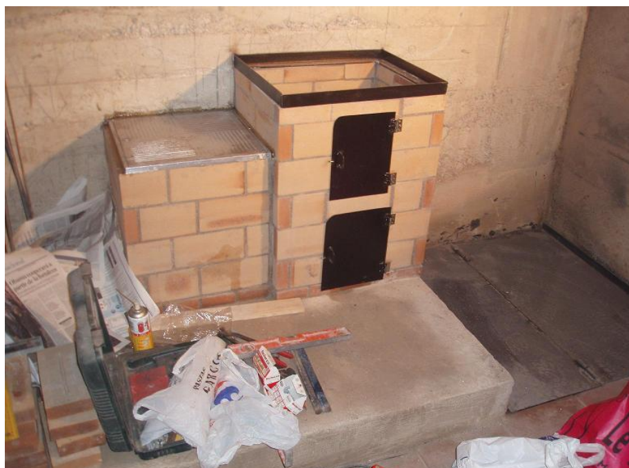
Ilustración 144 Construcción de horno refractario.
