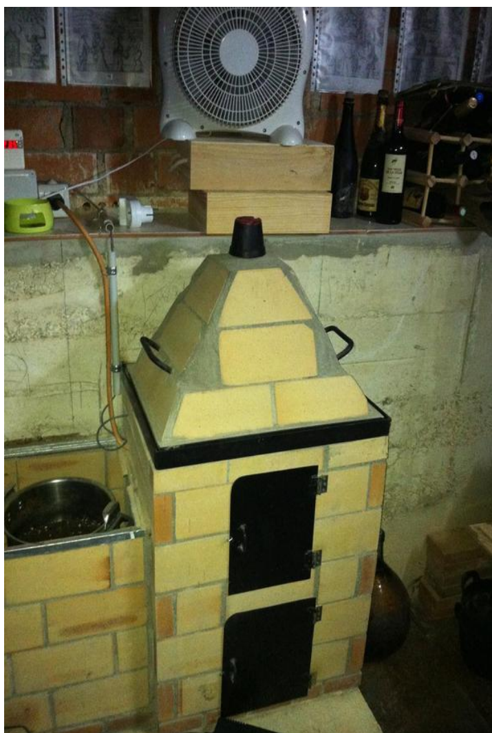
Ilustración 212 Horno de obra completo.
