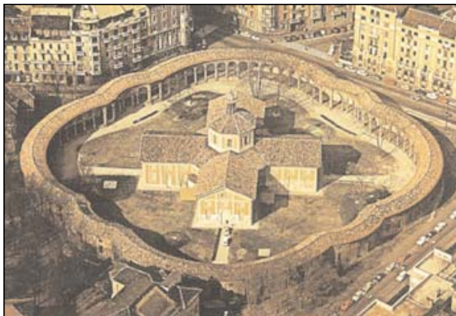
FIGURA 70. "La Rotonda", Milán. Edificio de planta incluída en un espacio circular; construido en círculos concéntricos y rematado por una cúpula. La cruz inscrita en el círculo, formada por las bóvedas que sostienen la cúpula central, se dibuja claramente en el exterior.
