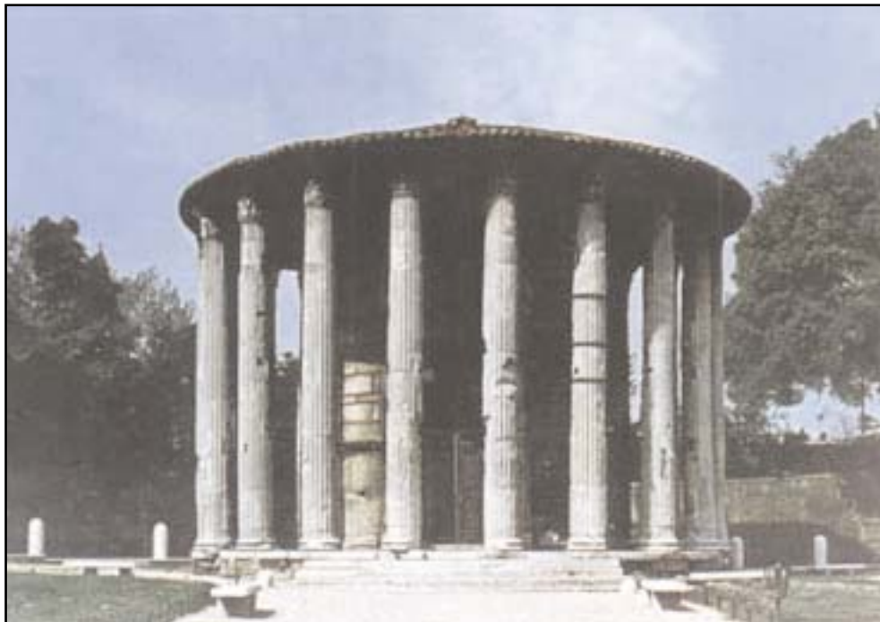
FIGURA 69. "Templo de Vesta", Roma. El cilindro del interior está revestido de columnas griegas que, así como el establamiento, en este caso no sostienen, sino que únicamente ocultan el juego de la bóveda.
