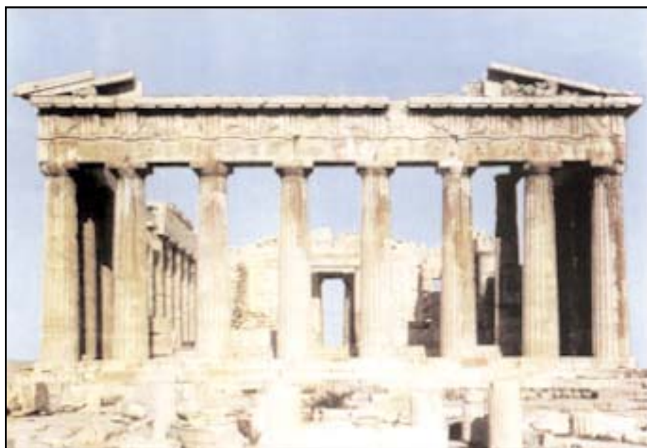
FIGURA 91. El Partenón (fachada oriental), de planta rectangular y proporciones alarga- das, la inclinación del eje de las columnas y las cubiertas de las líneas horizontales cooperan en la armo- nia del templo. (Grecia).
