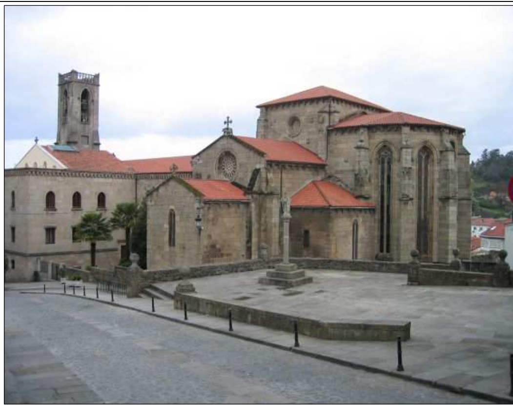
Iglesia de San Francisco de Betanzos, edificada probablemente sobre el solar templario.
