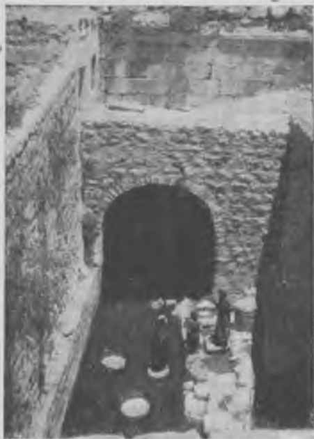
Piscina de Siloé. En alto se ven al fondo los restos de la basílica de Eudoxia.
