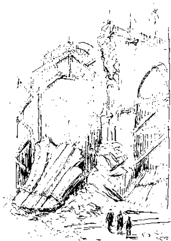
Ruina del segundo cimborrio en 1888.
