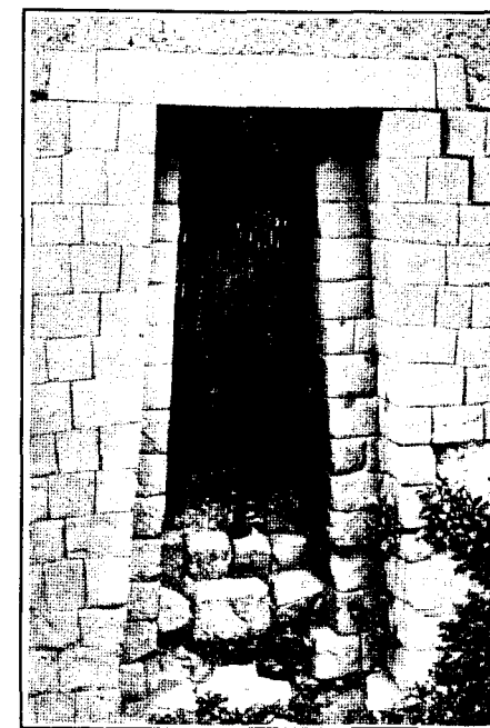
Una puerta trapezoidal, típica de las construcciones peruanas, en una casa del Cuzco. Los muros son de piedra regular, y el vano es un monolito. El estilo del monumento es el más perfecto y adelantado, y las piedras están unidas sin aplicación de mortero, lo que es otra característica de los edificios del Perú antiguo.
